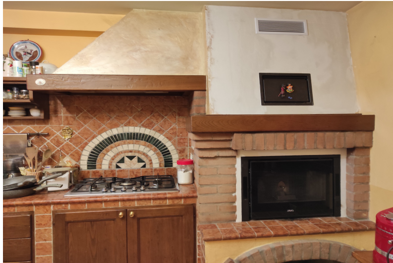
Caminetto Esistente con il nuovo inserto già installato (ante verniciatura finale)
