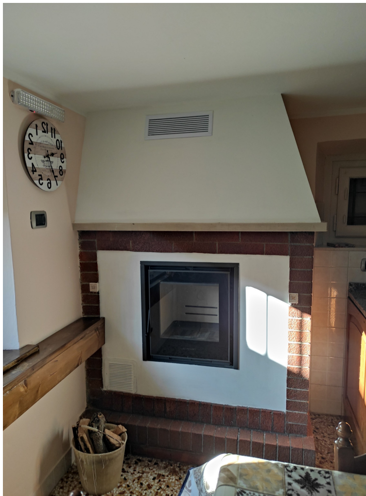
Fotografia del lavoro finito
